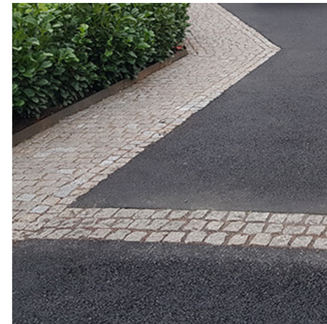
Asfalt med en fris av smågatsten, gårdarna fogas ihop med asfalt men visar ändå på en skillnad mellan fastighetsägare med hjälp av smågatstenen
